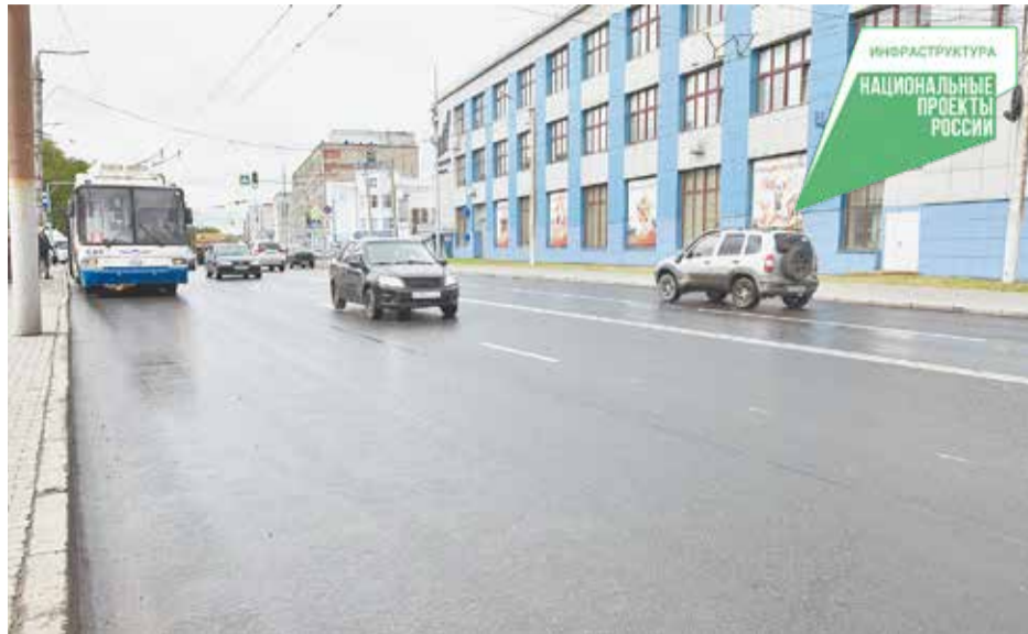
Отремонтированный участок Октябрьского проспекта.
